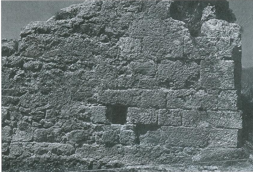
Fig. 7 - Castrum di Orco: particolare della muratura della torre sommitale
