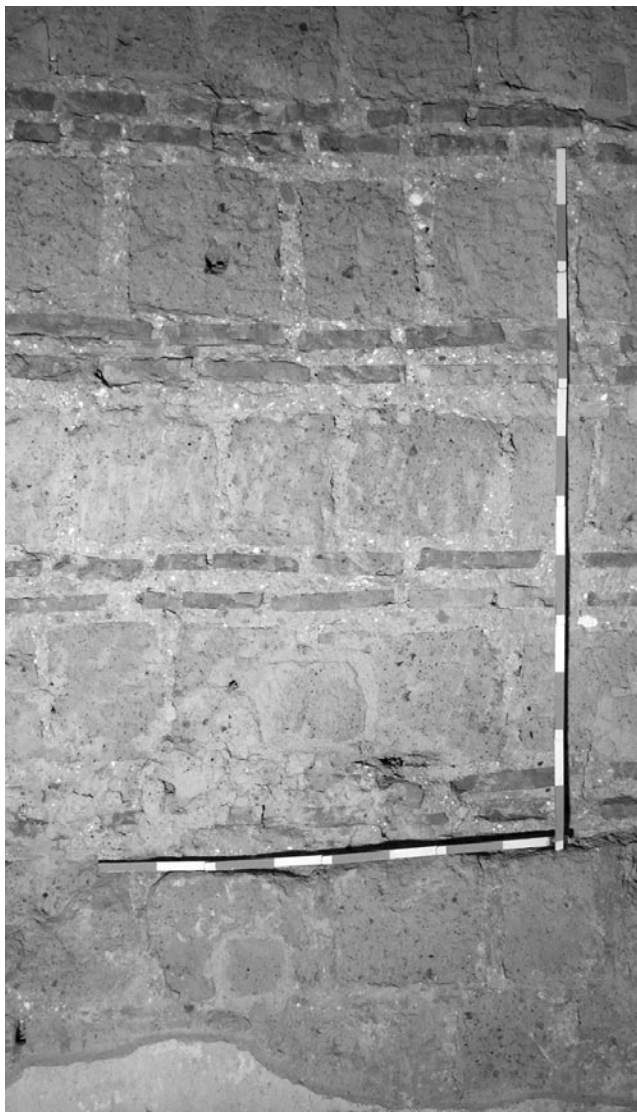
Fig. 29. Paramento in opera vittata mista dell'abside di San Giovanni Maggiore (fotografia C. Ebanista).
