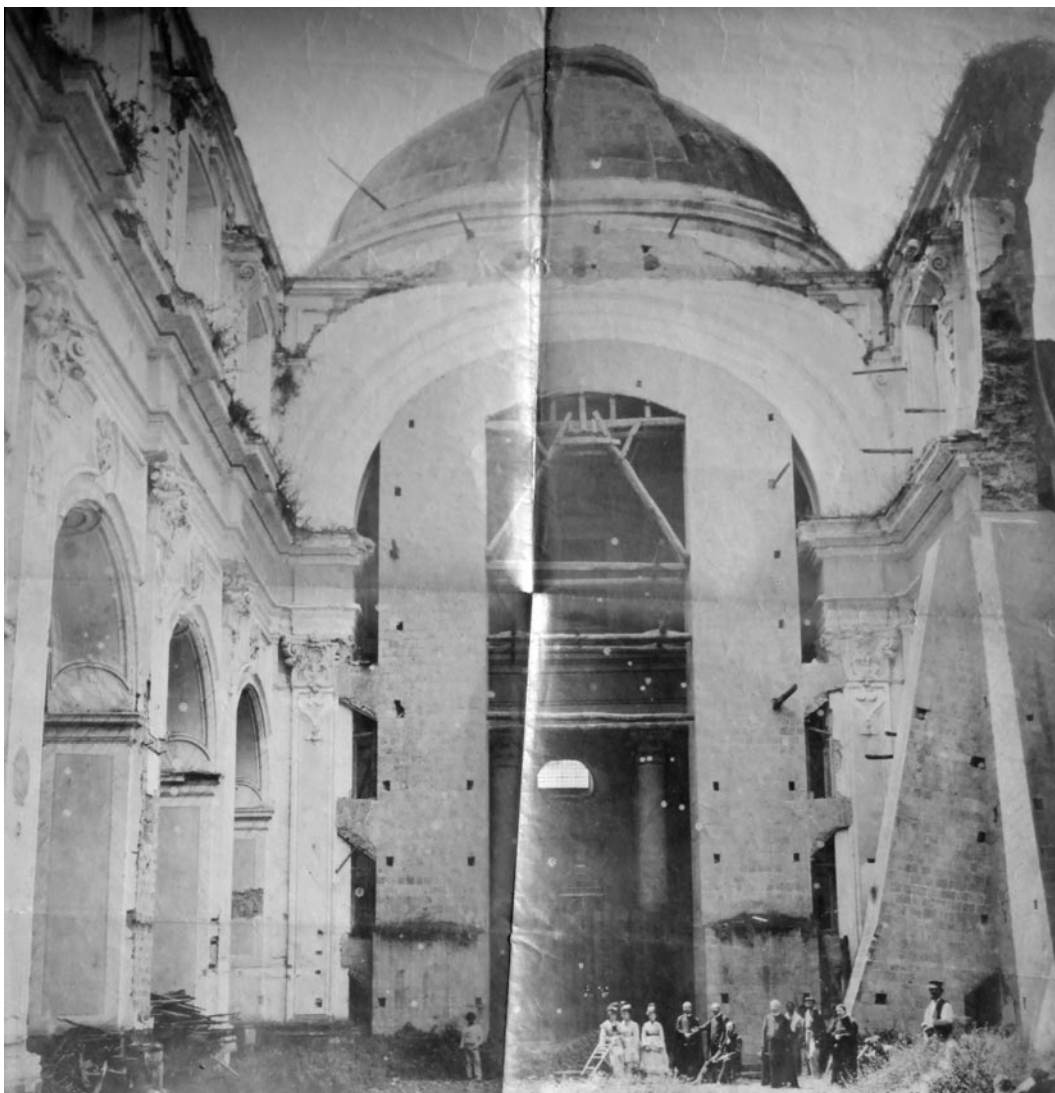
Fig. 12. I ruderi della chiesa di San Giovanni Maggiore (1872), in ASDN, Collegiata di S. Giovanni Maggiore , fascio 177 (già fascio III), 1870-1881. Documenti relativi alla riedificazione della Chiesa.
