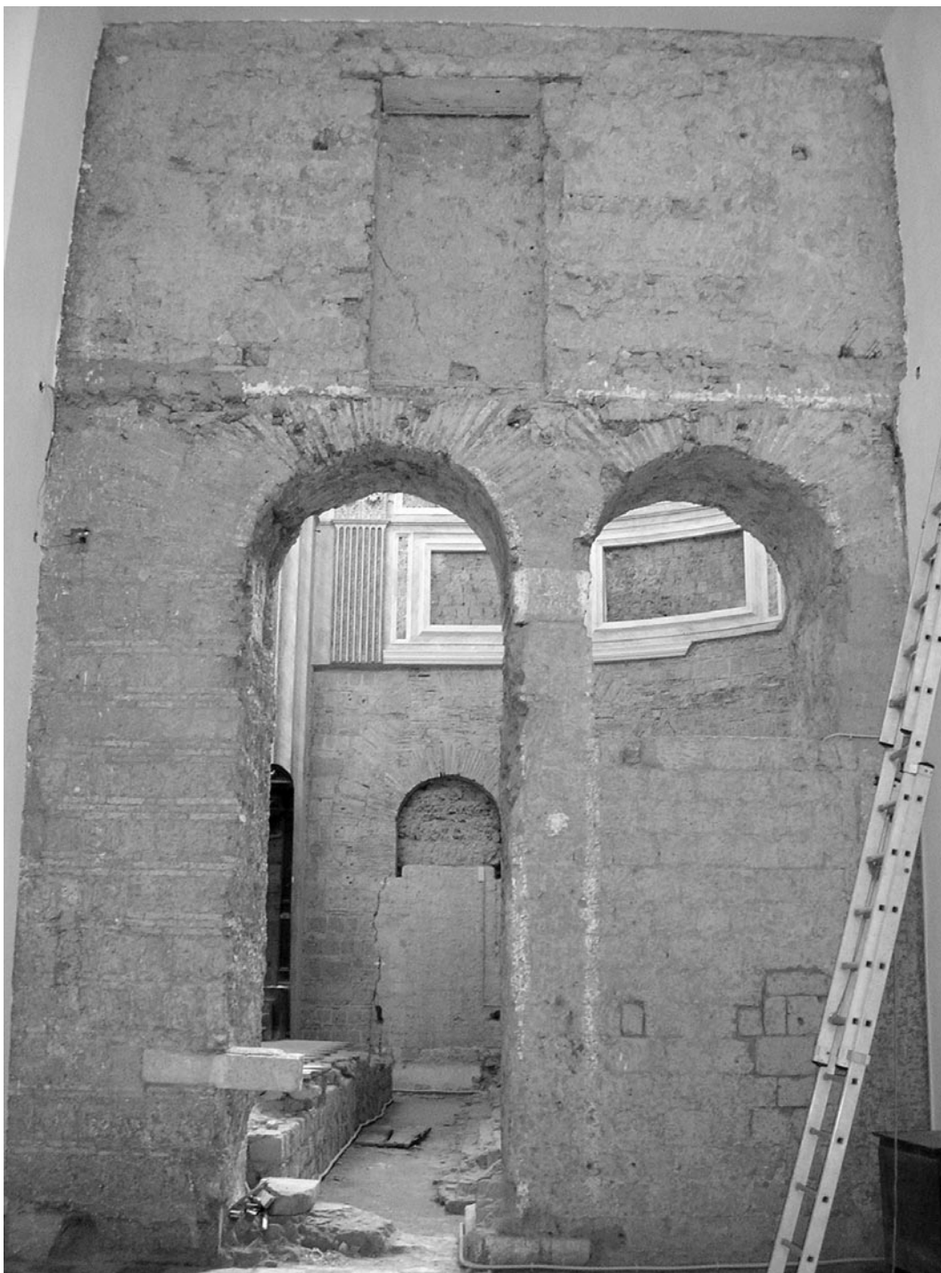
Fig. 34. Sagrestia della chiesa di San Giovanni Maggiore, il retro della bifora sinistra dell'abside prima dei lavori del 2006-09 (fotografia C. Ebanista).
