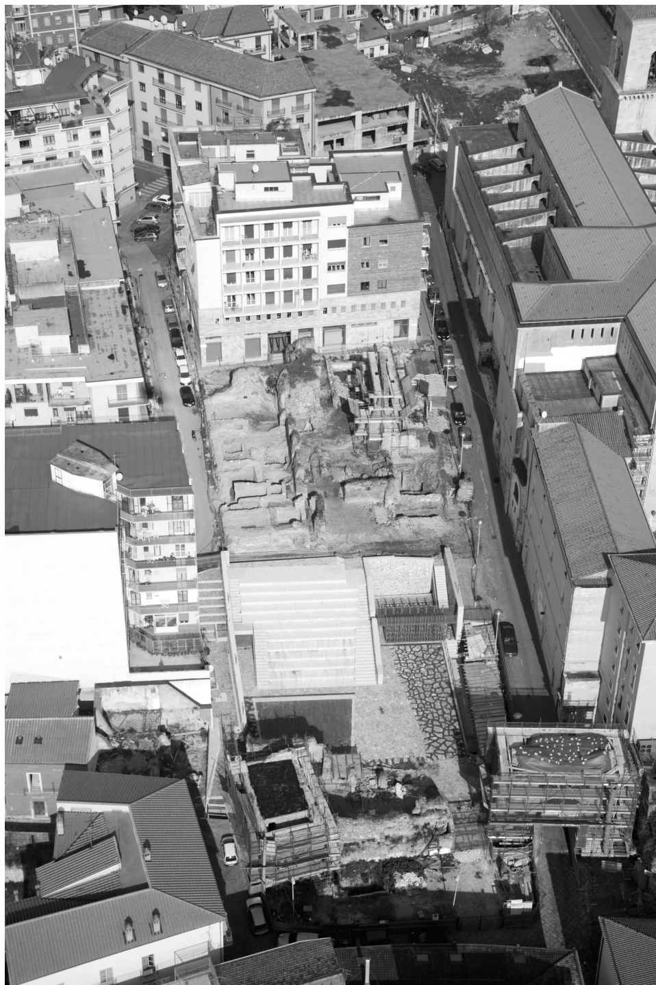
Fig. 23. Area dell'arco del Sacramento, veduta obliqua durante i lavori.
