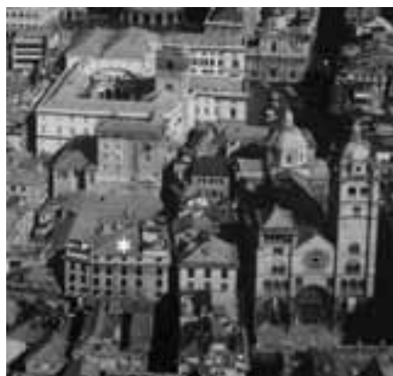
Fig. 5 - Il quartiere della cattedrale di Genova (con indicazione dell'ubicazione del chiostro dei canonici)
