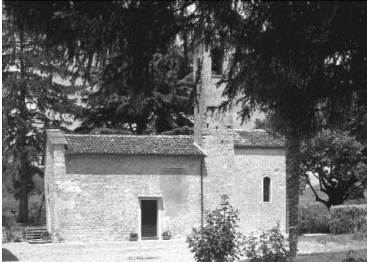
La chiesa di San Micheletto, dopo i recenti restauri.
