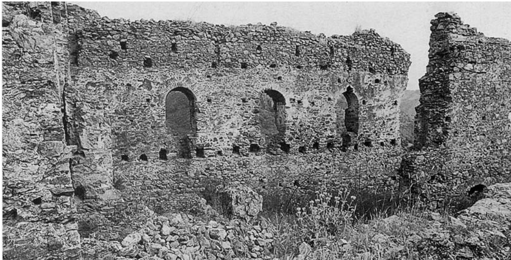
Fig. 7 - Area 2000. Lato E, interno
