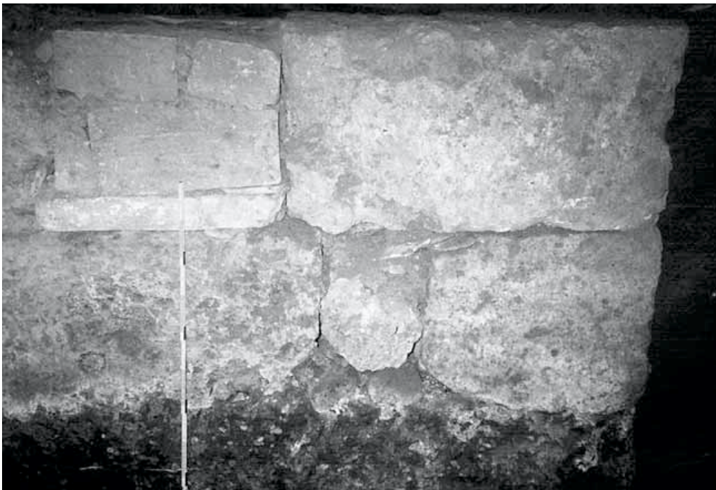
Fig. 17 – Muratura realizzata in travertino reimpiegato in occasione del cantiere del XII secolo (us 1305, fase 4).
