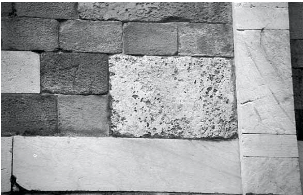
Fig. 18 – Concio in travertino proveniente dalle mura tardorepubblicane reimpiegato nell'edificio del XII secolo (fase 4).
