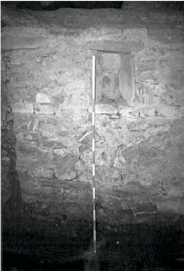
Fig. 10 – Muratura della cripta di età carolingia (us 1364, fase 3.5).
