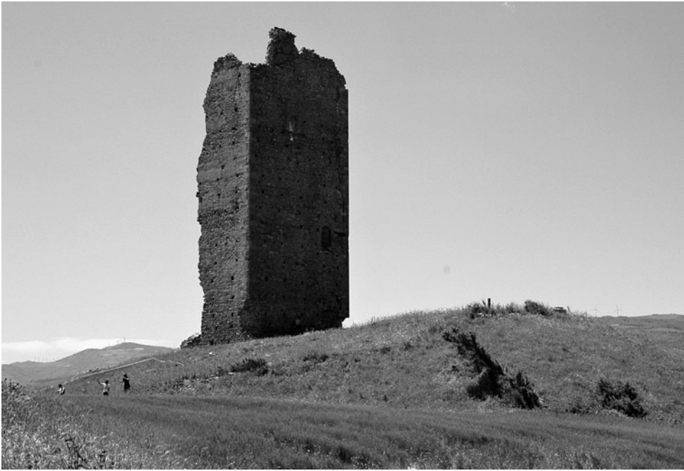
fig. 7 – Montecorvino. Torre dell'impianto castrense, eretta su un rialzo di terreno, verosimilmente una motta.
