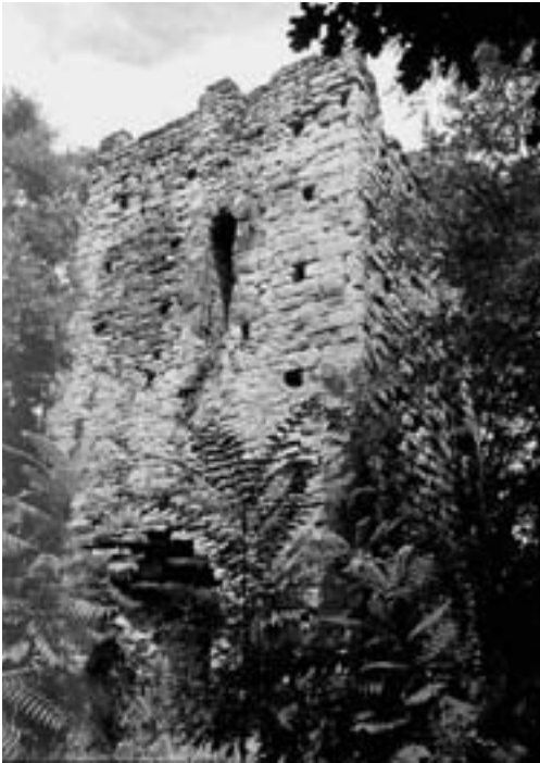
A Pianetto, in comune di Santa Sofia, la torre è probabilmente ancora quella menzionata nei documenti del XII secolo. All'interno è perfettamente leggibile l'organizzazione dei vani e l'autosufficienza funzionale e difensiva della struttura.
